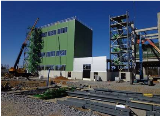
Prosessivesirakennuksen kuorirakenteet ovat valmistumassa
