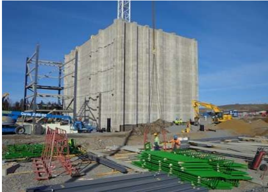
Uusi uljas jätebunkkeri kokonaisuudessaan - bunkkeri nousee maanpinnasta 22m ylöspäin
