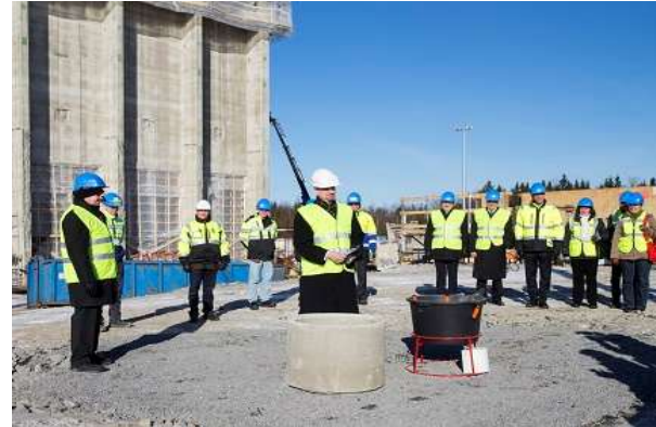
Peruskivi muurattiin aurinkoisessa säässä 17.3.2014.
