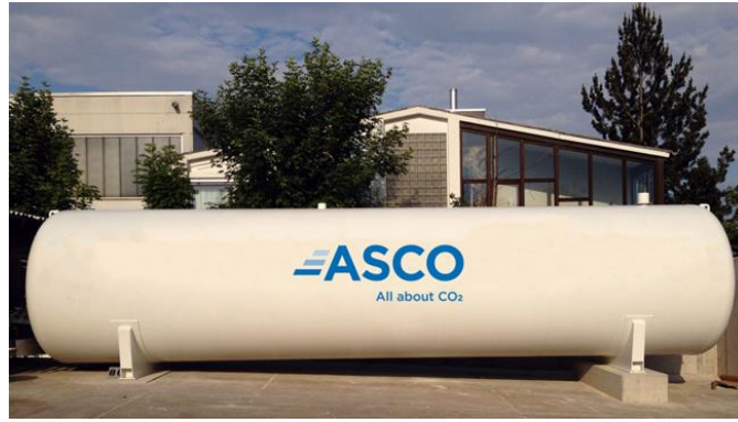
Kuva 11. Vaaka-asenteinen hiilidioksidisäiliö.
